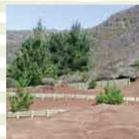
Erosión y medidas de contención, Isla Robinson Crusoe
